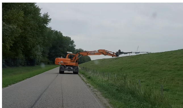
Рис. 2. Зондирование дамбы при помощи автокрана.
